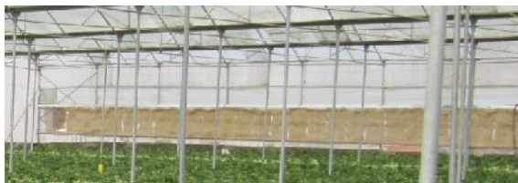
شکل ۷) نصب سیستم فن (بالا) و پد (پائین) در گلخانه‌ها
