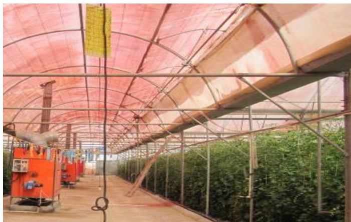
شکل ۶) سیستم گرمایشی در راهروی وسط گلخانه
