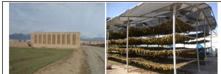
A - بارگاه‌های سیمی و سنتی برای خشک نمودن و گوگرد دهی
